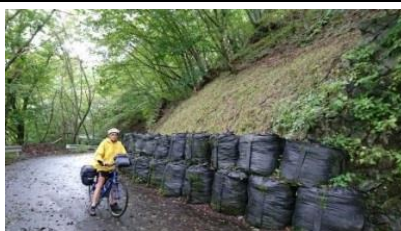
崖崩れの現場
